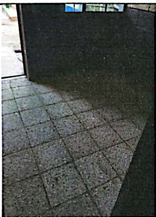
Foto 3: MEJORAMIENTO Y SUSTITUCION DE PISO
