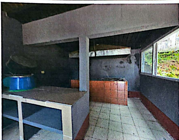
Foto1: REPARACIÓN O SUSTITUCIÓN DE ÁREAS DE COCINA
